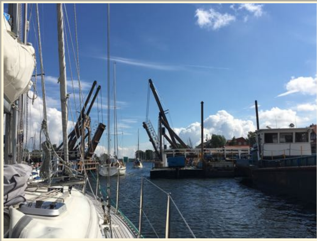
Die alte Holzklappbrücke in Wieck auf dem Weg nach Greifswald
